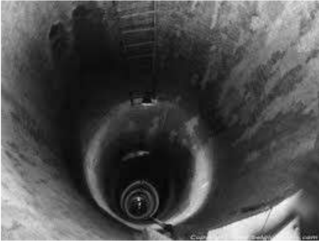
De 56 meter diepe waterput
