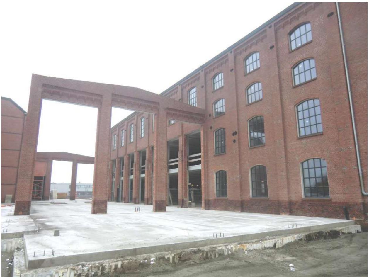
De Zeeland, hal 2 tijdens restauratie
