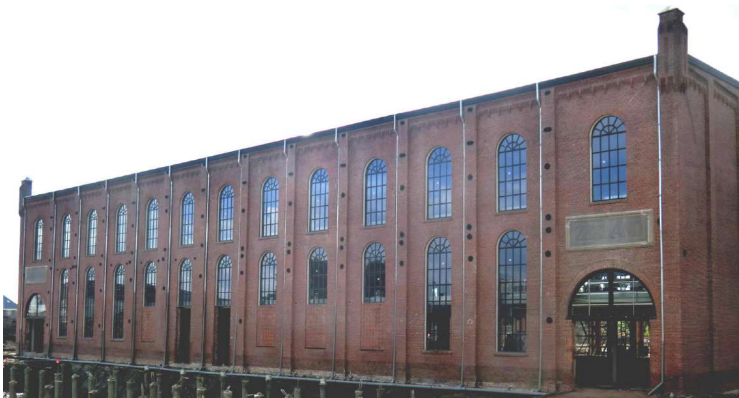
De Zeeland, hal 3 tijdens restauratie
