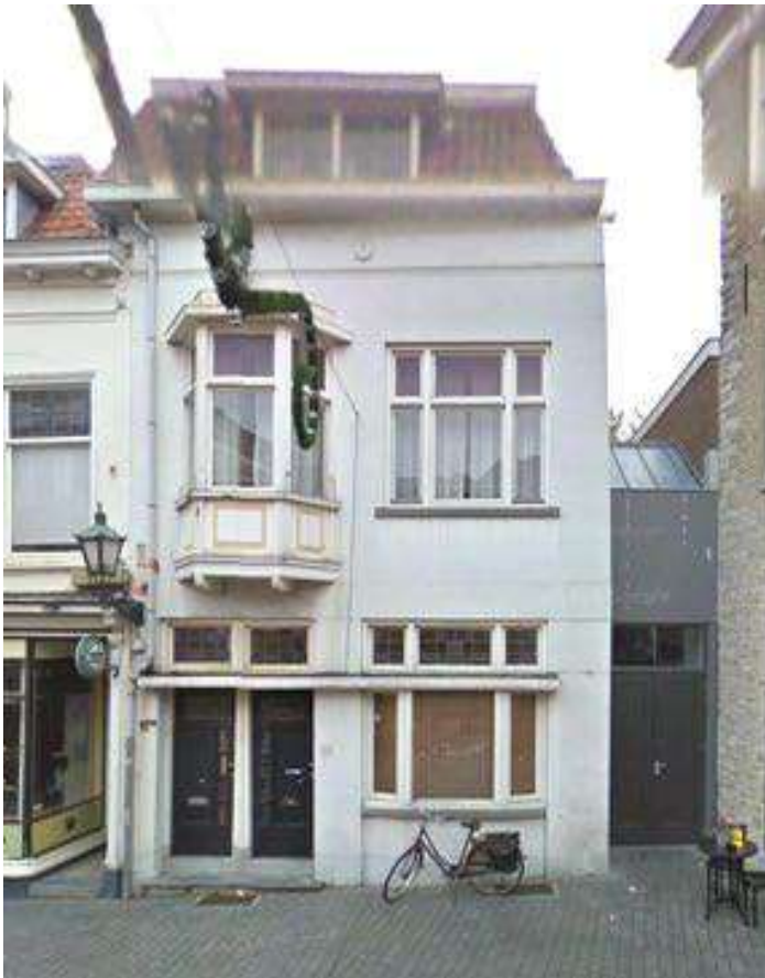
Het huis voor de verbouwing (foto Google Streetview)
