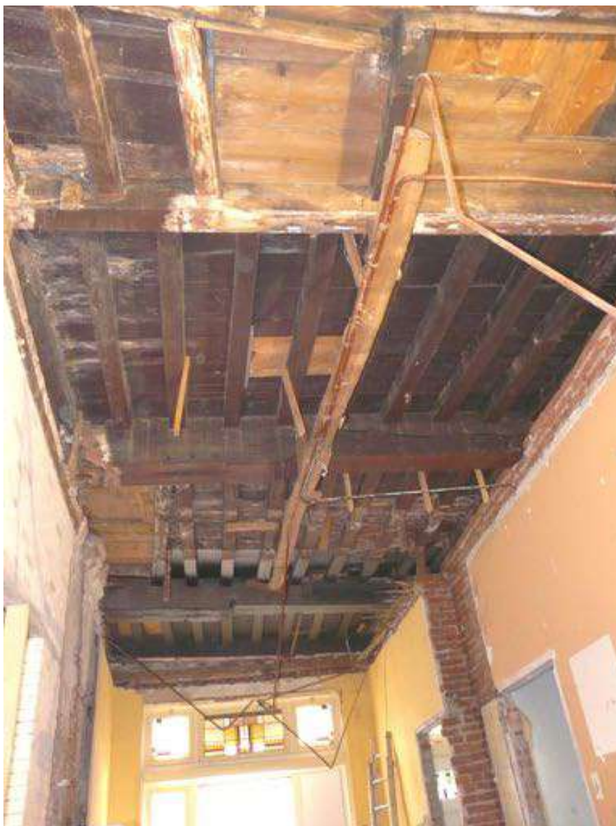
De verdiepingsbalklaag tijdens het strippen van het pand
