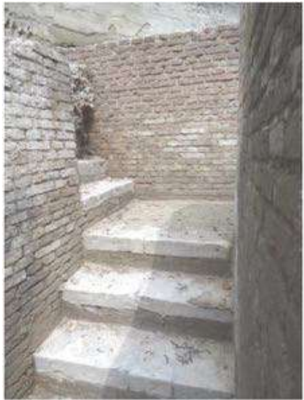
Detail van muurwerk in proefsleuf 1: de trappen.
