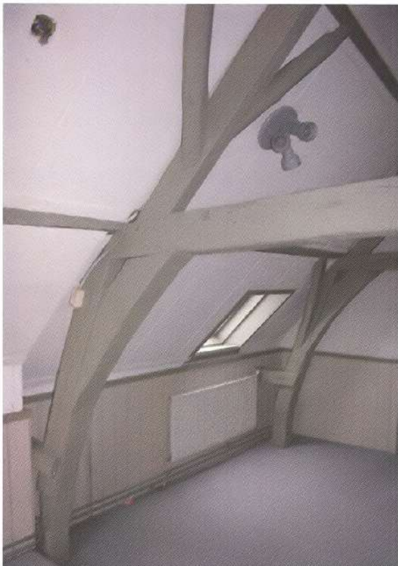
Een zicht op de eerste twee spanten in de kap van Blauwehandstraat 3 die gekenmerkt worden door de enigszins archaische vormgeving en mede op basis daarvan te dateren in de 16 de , mogelijk zelfs 15 de eeuw.
