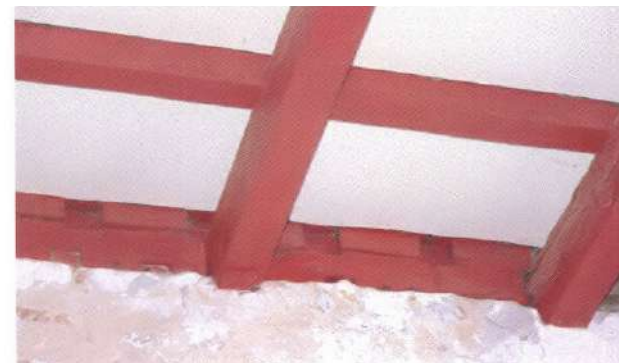
Een detail van de balk in de voorgevel met kepen voor de verdwenen kinderbinten en toognagelgaten aan de onderzijde van de balk
