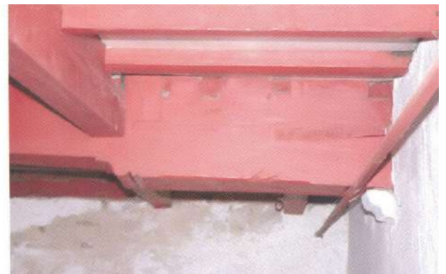
Een detail van de opletting van de tweede moerbalk met duidelijk op de foto de profilering van het sleutelstuk en de console.
