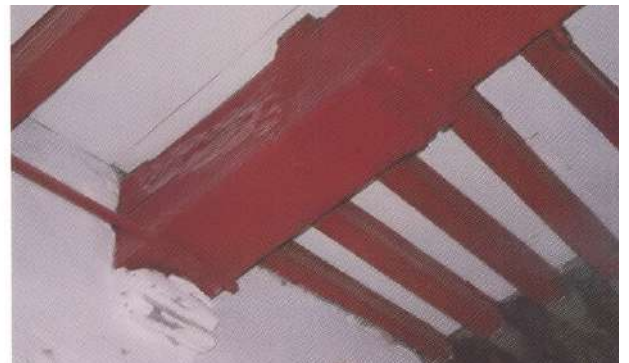
Een detail van de opletting van een van de moerbalken met een sleutelstuk en een console.
