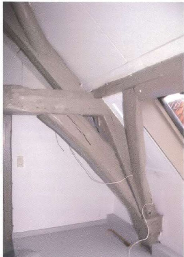
Detail van het rechter spantbeen van het eerste spant met het telmerk II.
