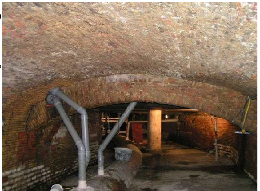
De Grebbe tijdens restauratiewerkzaamheden ter hoogte van de Geweldigerstraat
