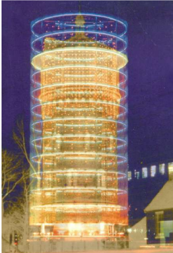
De watertoren als reclamezuil
