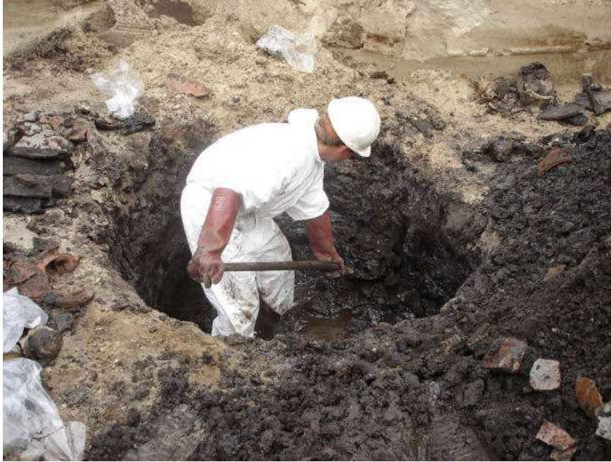
Aan het werk bij de sanering van de gasbriek
