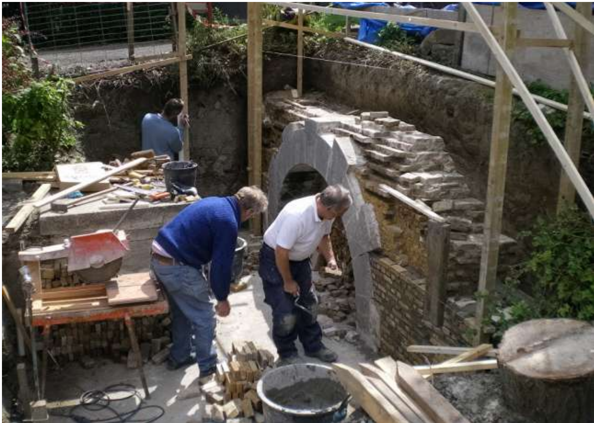
De restauratie in volle gang
