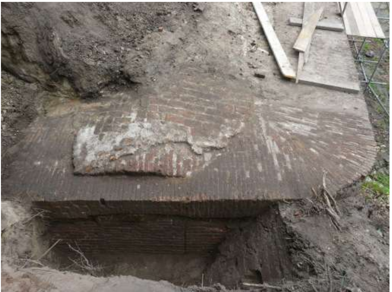
De dichtgezette doorgang in de contrescarp
