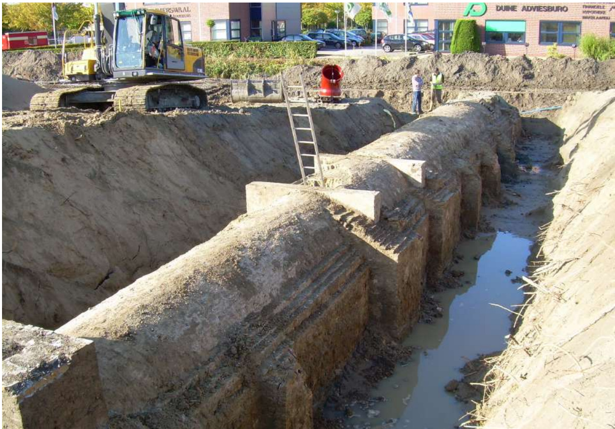
De duiker, gezien vanuit het oosten, in de richting van de Bergse Plaats. De ladder staat tussen de twee sluisdeuren, herkenbaar aan de witte natuurstenen platen.
