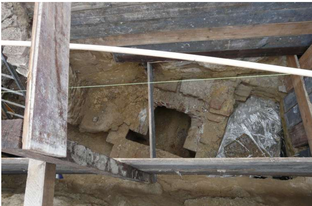
De bouwput met daarin de mijngang
