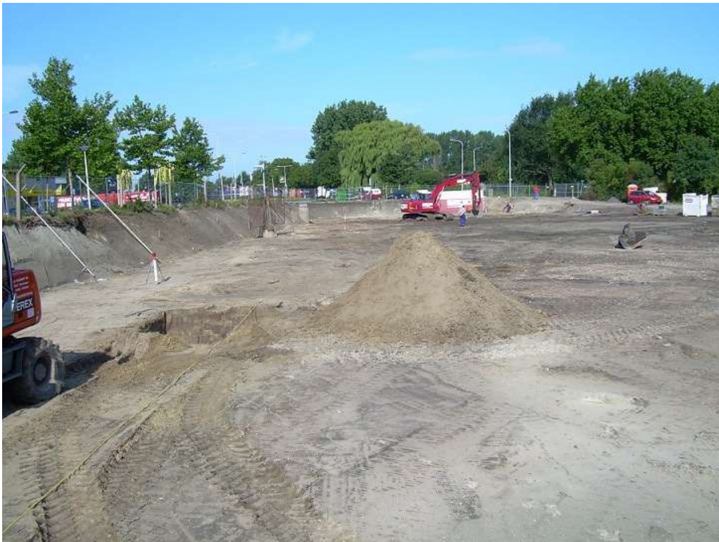
het terrein van de werf na de sanering en gedeeltelijke afgraving.
