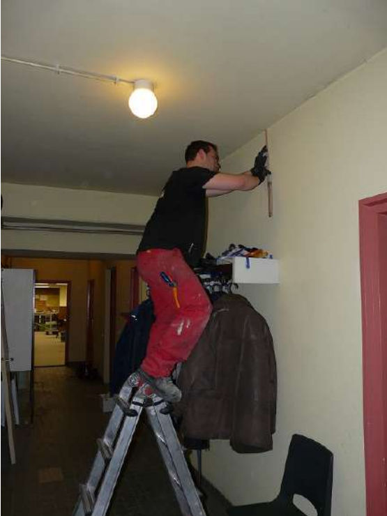
Matthew van Jefko Techniek legt de brandmelders aan
